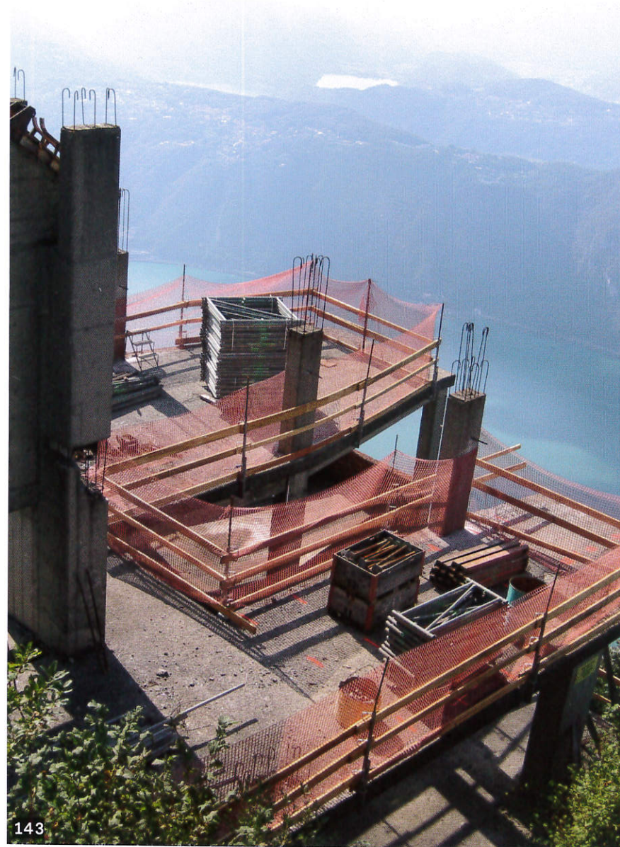
143. Messa in sicurezza del cantiere.
